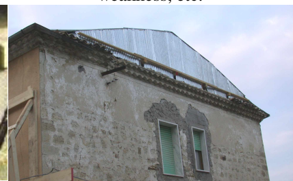
o) out-of-plane tympanum overturning
