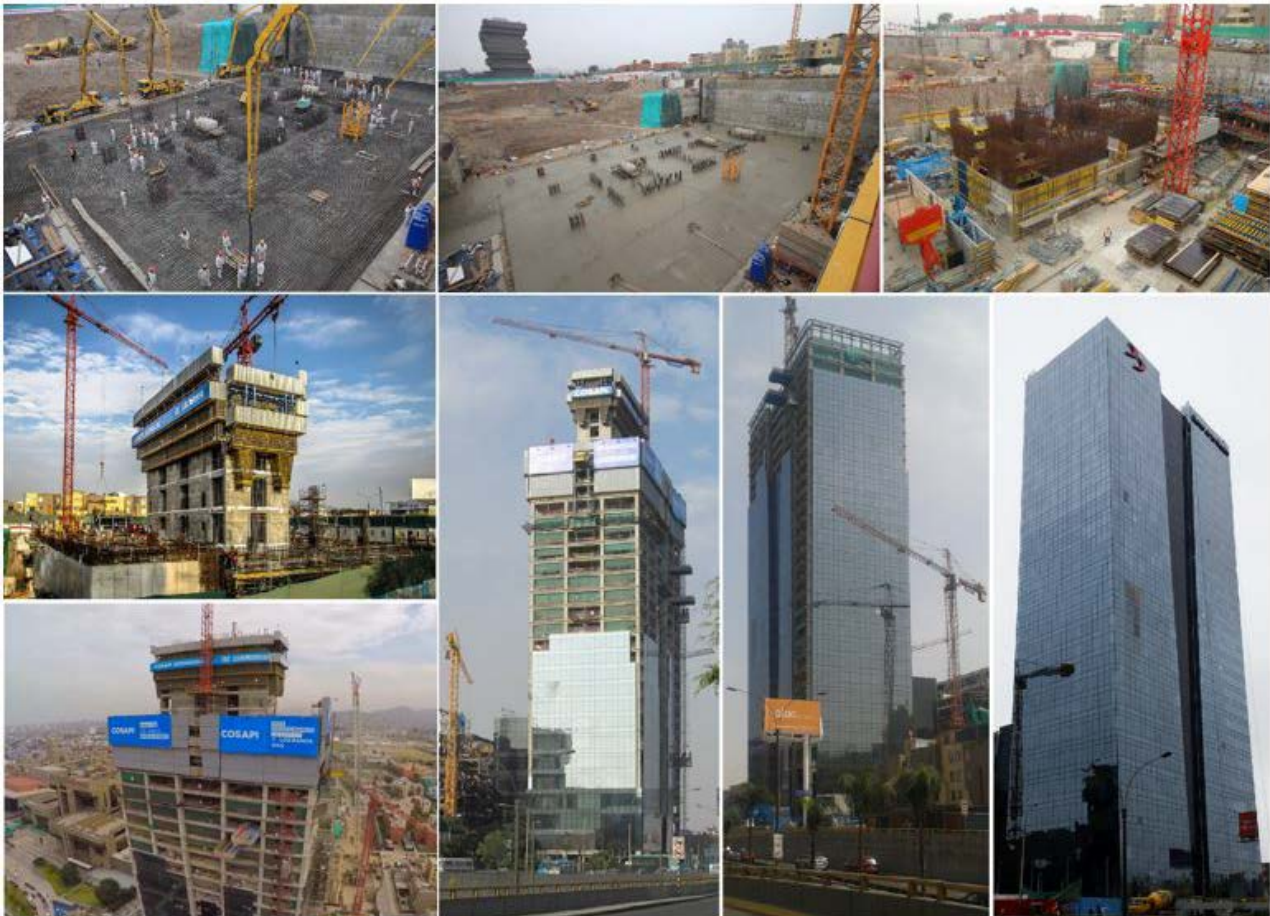
Fig. 12 – Construction of the “Banco de la Nación” Tower.
