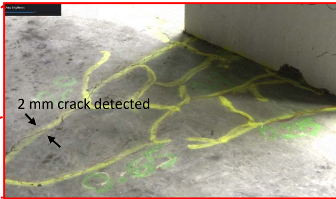
(d) Damage data collected using RTC360 scanner
