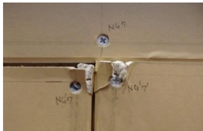
(d) Gypsum board joint damage (1/50 rad)
