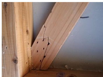
(d) Lower end of N side bracing when dismantling
