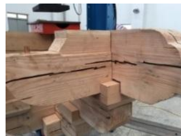
(d) Development of upper horizontal cracks
