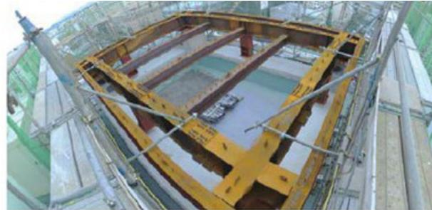
(d) Steel frame for TMD weight
