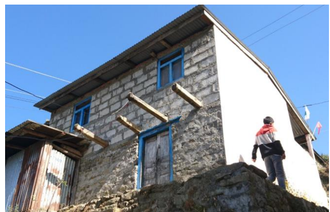
HCB construction in Rasuwa
