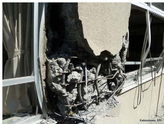
(d) Damages to column in south frame
