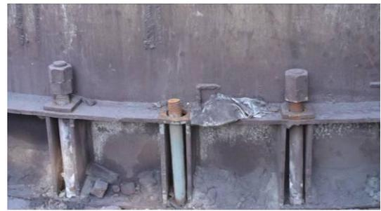
(d) Stretching and fracture of anchor rods
